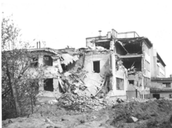
Ruiny budovy gymnázia
