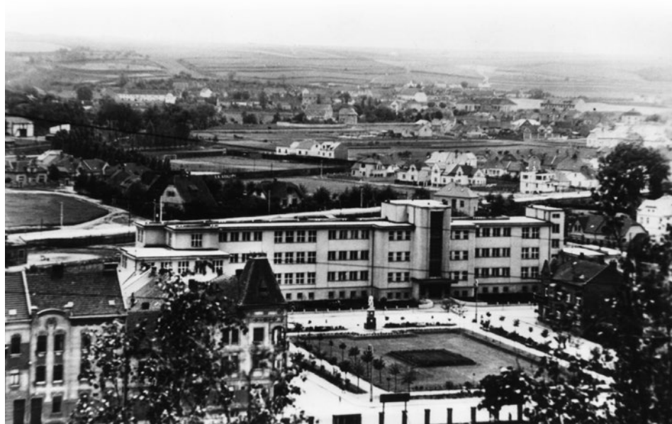
↑ | Pohled na novou budovu gymnázia před dokončením (1929-30)
